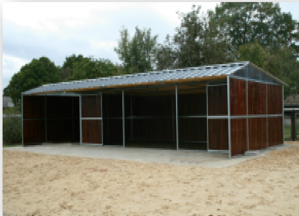
Offenstall mit Remise
