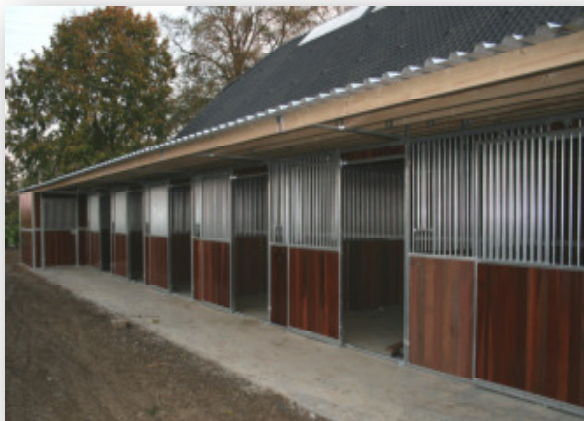
Pulldach mit Trapezblech an Scheune
