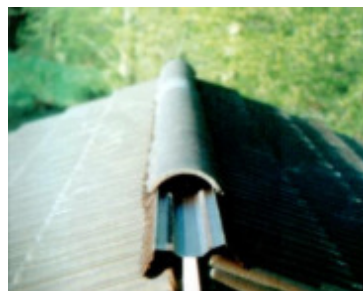
Entlüftung über den Dachfirst
