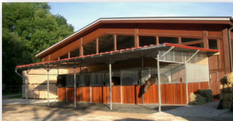
Offene Außenboxen an Reithalle
