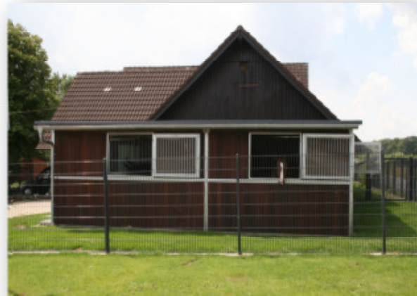
Pulldach an Hauswand
