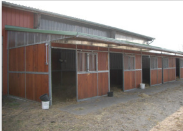
Außenboxen an Reithalle
