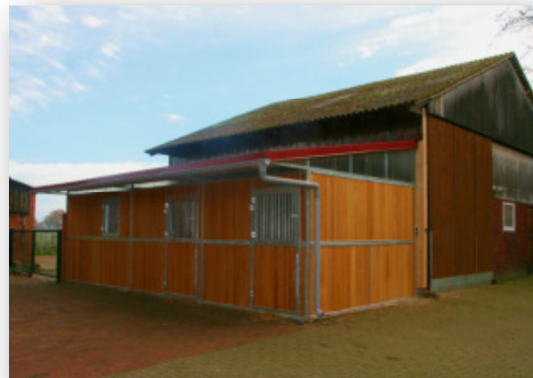
Pulldach mit Trapezblech an Scheune
