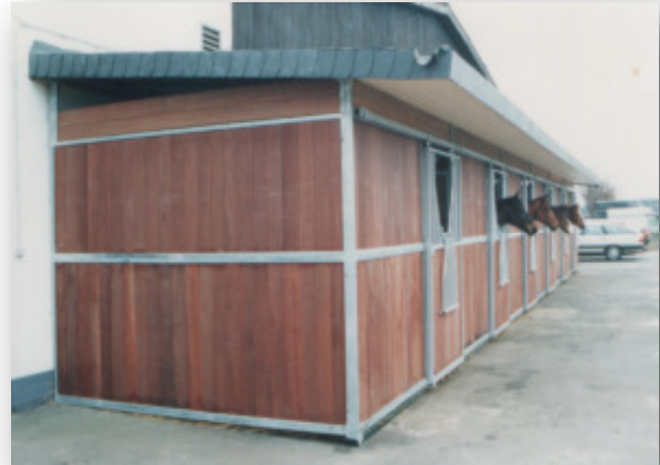
Pferdestall an Hauswand
