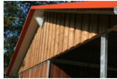
Deckelschalung im Giebel
