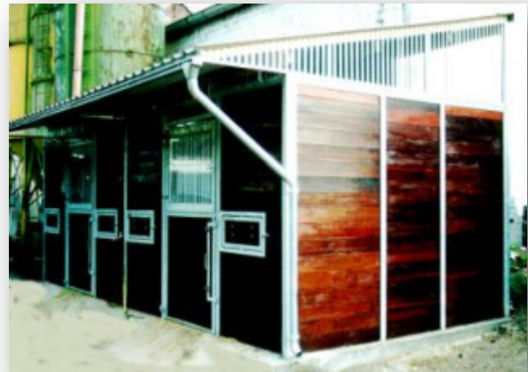
Außenboxen an Reithalle
