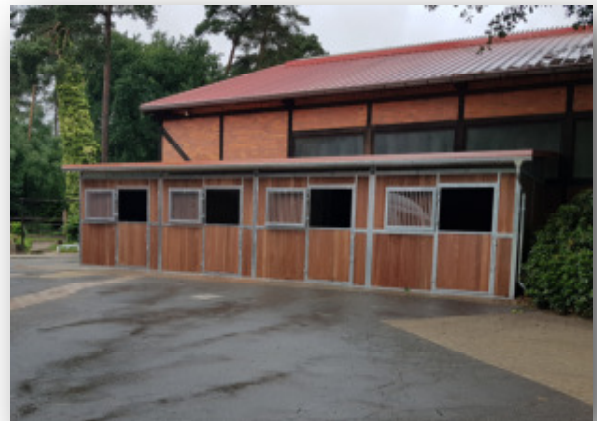
Außenboxen an Reithalle
