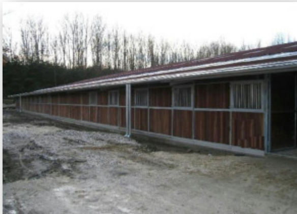
Pulldach mit Eternit an Reithalle
